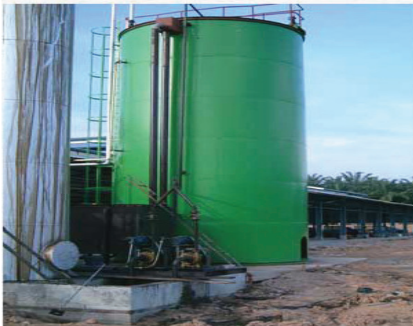
รูปภาพที่ 27 นำของเสียจากกระบวนการผลิตเข้าถังเก็บตะกอน
