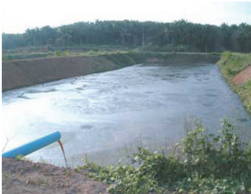
รูปภาพที่ 28 ปล่อยน้ำเสียจากกระบวนการผลิตลงบ่อบำบัดน้ำเสีย
